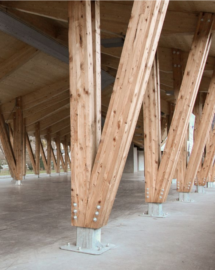
Halle de Fillings (74) ▲ 50% des bois utilisés proviennent de la forêt communale. Un travail en étroite collaboration avec l'ONF. Livraison : 2020 | Architecte : N&BO BET Bois : Gustave
